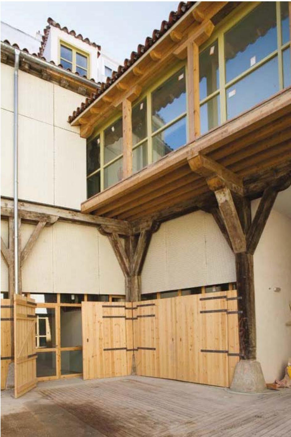
La fachada del patio, conservando los antiguos huecos, se descompone por elementos en planos superpuestos: el entramado de madera, la plementería de plancha blanca y un cerramiento continuo acristalado, que permite la comprensión, desde el interior, de los componentes.
