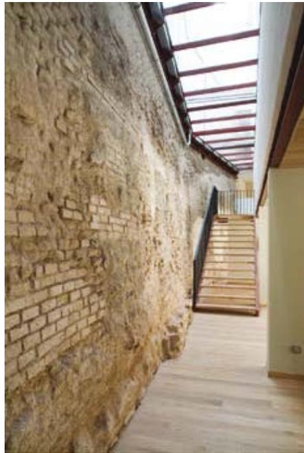
Por encima de esta cota se mantiene la estructura de pilares, jácenas y forjados de madera, igual que los muros interiores de entramado de madera con relleno. Se ha recuperado gran parte de la madera existente sustituyéndose, sólo puntualmente, algún elemento dañado.
